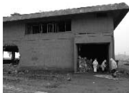
被災した陸前高田市立図書館での作業(裏手より)
